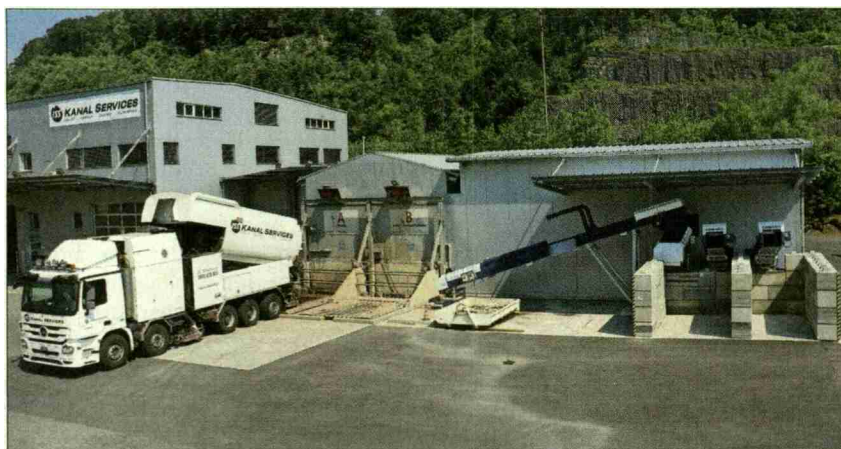
Die ISS Kanal Services AG in Kägiswil hat eine Abwasseraufbereitungsanlage mit Fraktionentrennung in Betrieb genommen.
