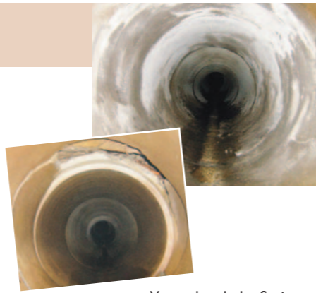
Vor und nach der Sanierung
